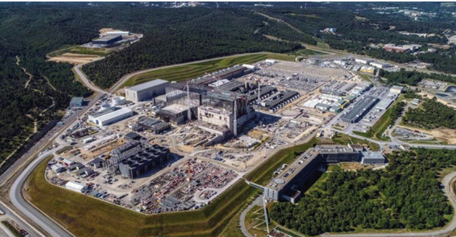
〈그림 2〉프랑스 카다라쉬에 건립 중인 국제핵융합실험로(ITER)
